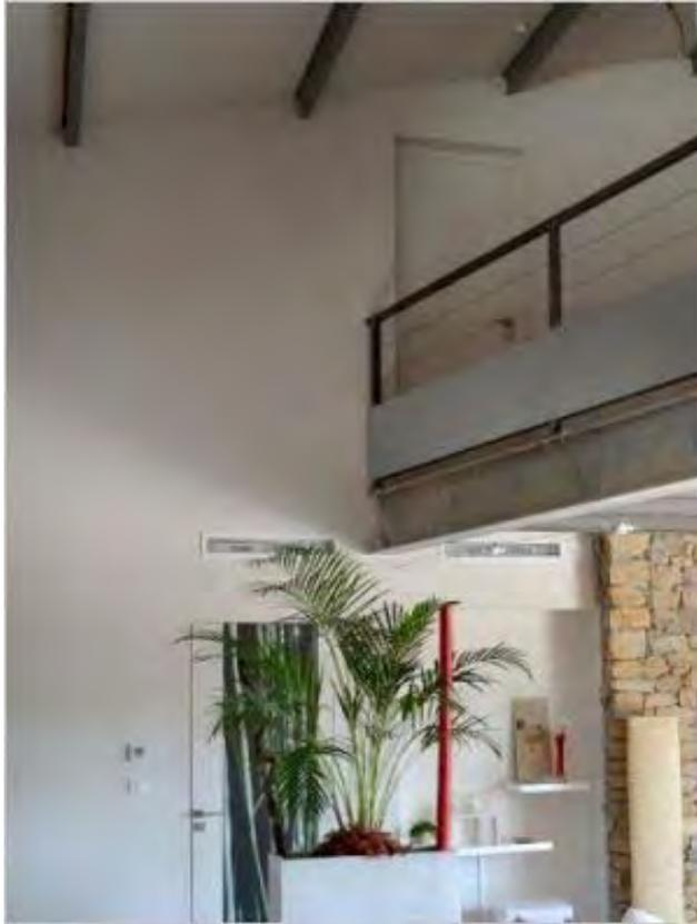
Le vide sur séjour est soutenu par une poutrelle métallique (IPN) laissée apparente, pour ajouter à l'aspect brut de la maison.
